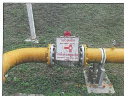
รูปที่ 2-44 ระบบท่อ Bypass และระบบวาล์วสำรอง
