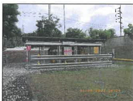
รูปที่ 2-48 สถานีควบคุมความดันและวัดปริมาณก๊าซ
