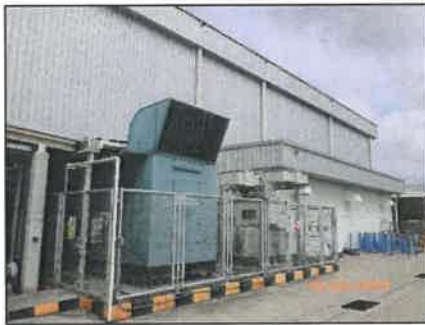
รูปที่ 2-51 เครื่องผลิตกระแสไฟฟ้าสำรองขนาด 700 kVA สำหรับโครงการโรงงานผลิตเส้นลวดทองแดงที่ไม่มีออกซิเจน
