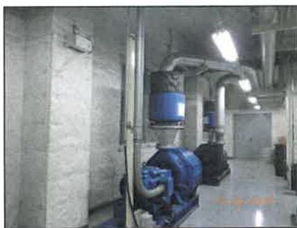
รูปที่ 2-14 การปิดครอบเครื่องจักรและอุปกรณ์ที่มีเสียงดัง และผนังกันเสียง
