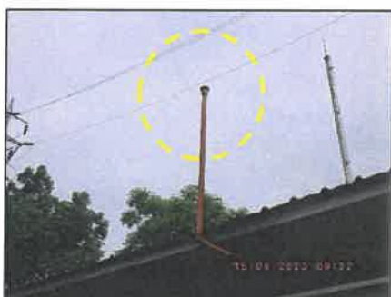
รูปที่ 2-45 ปล่องระบายก๊าซ (Blow down stack)
