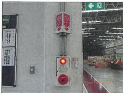
รูปที่ 2-39 ระบบตรวจจับและสัญญาณเตือนภัยอัตโนมัติ
