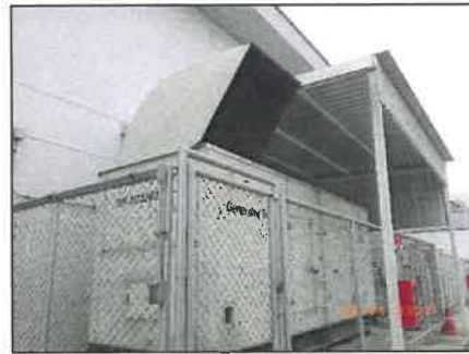
รูปที่ 2-52 เครื่องผลิตกระแสไฟฟ้าสำรองขนาด 600 kVA สำหรับโครงการโรงงานผลิตเส้นลวดทองแดง ที่มีออกซิเจน
